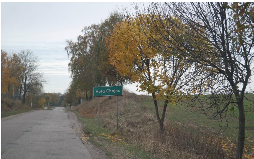
Fot. 23. Droga powiatowa 2130C stanowiąca skomunikowanie z obszarem nr 4 objętym zmianą studium
